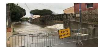
Sécurisation passage à gué
